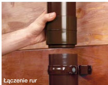
Montaż rur do ściany murowej
