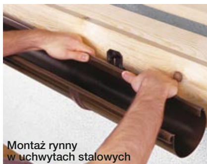
Montaż złączki rynny
